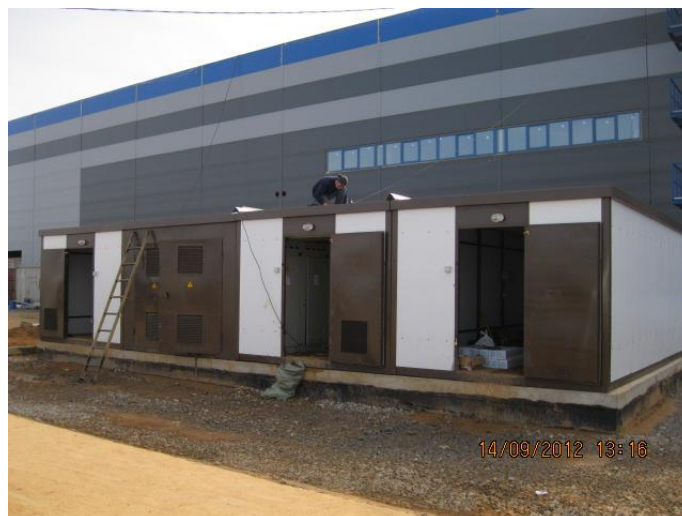
Фото 2. 2КТПНУ-1000, утеплённая для ООО «ФорумТверь», ТПЗ Боровлёво, г.Тверь
