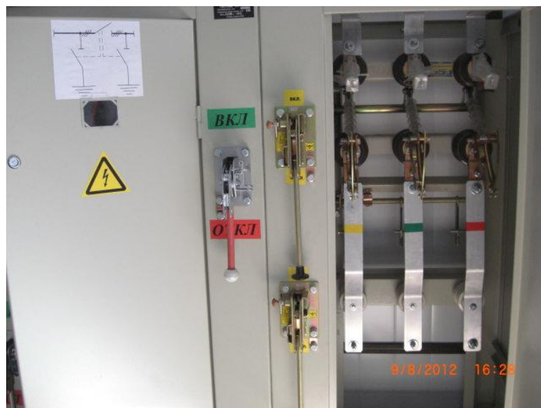
Фото 2. Камера КСО-393-03 УЗ (ВНА-10/630)
