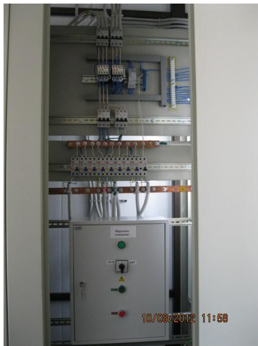
Фото 2. Панель ЩО70 с ящиком собственных нужд в РУ-0,4 кВ 2КТПНУ-1000/10/0,4 У1
