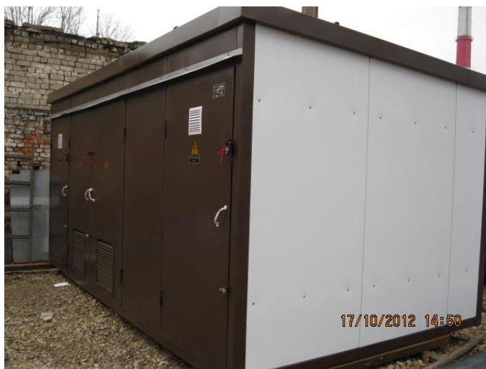
Фото 4. КТПНУ-1000, утеплённая для ООО «Доор-Хан», г.Осташков, Тверская обл.
