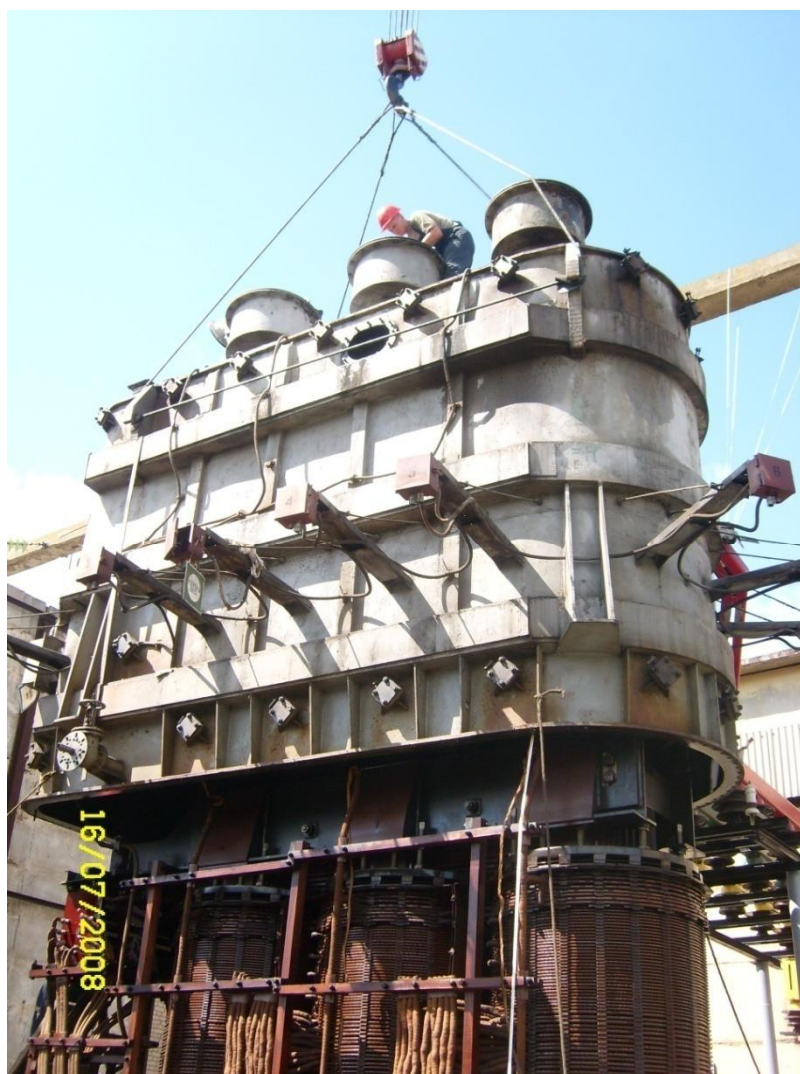
Фото 14. Ремонт трансформатора ТДТН-63000 кВА 110 кВ, газоперекачивающая станция, г.Орёл
