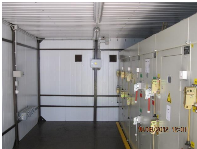
Фото 7. Распределительное устройство 10 кВ в 2КТПНУ-1000 ООО «ФорумТверь», ТПЗ Боровлёво, г.Тверь
