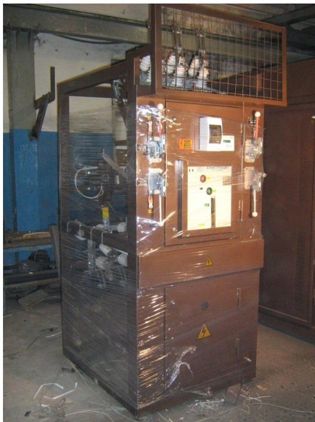
Фото 3. Камера КСО-298-8ВВ (ВВУ-СЭЩ, УЗА-10А)
