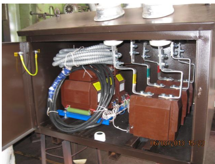
Фото 2. Пункт коммерческого учета электроэнергии типа ПКУЭ сх.3ТТ+3ТН
