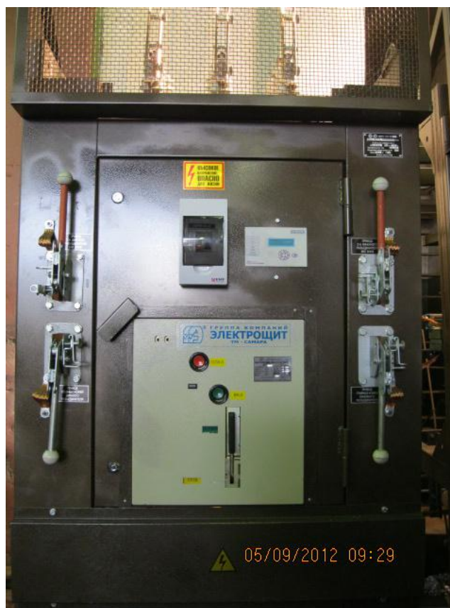
Фото 4. Камера КСО-298-8ВВ (ВВУ-СЭЩ, УЗА-10А)
