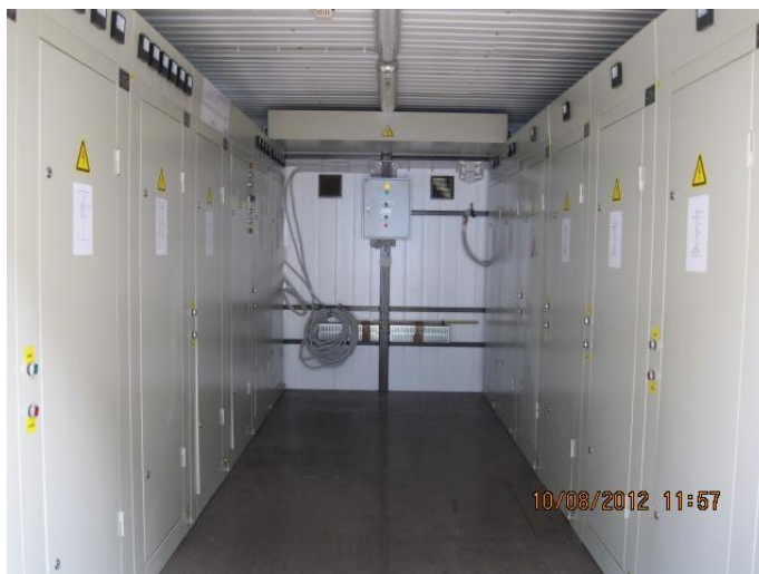
Фото 6. Распределительное устройство 0,4 кВ в 2КТПНУ-1000 ООО «ФорумТверь», ТПЗ Боровлёво, г.Тверь
