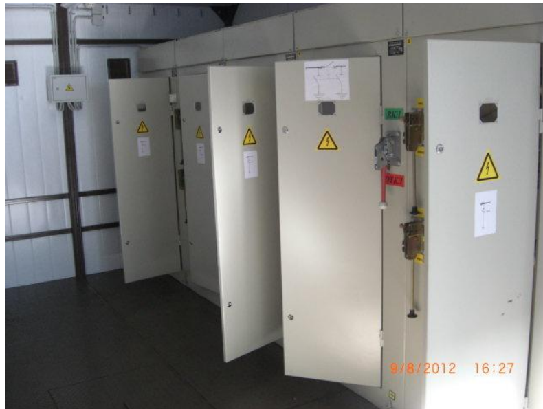
Фото 1. Распределительное устройство 10 кВ с установленными КСО-393
