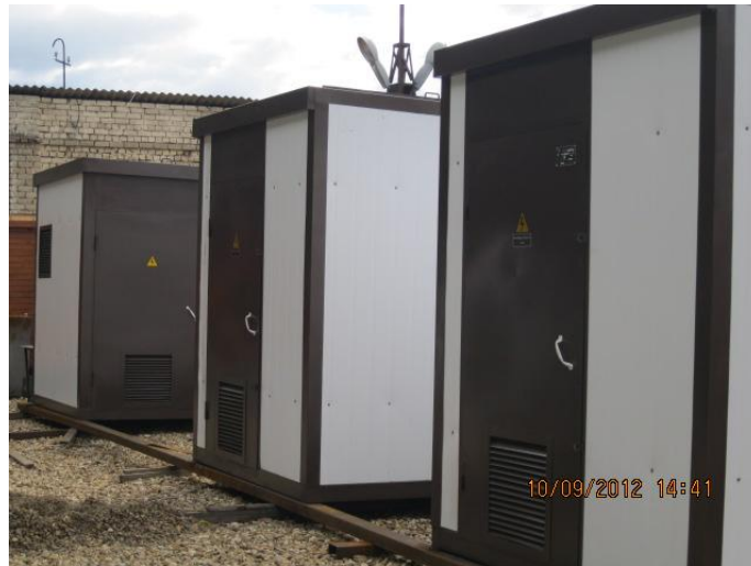
Фото 1. 2КТПНУ-1000, утеплённая для ООО «ИнженерЭлектроСтрой», г.Тверь
