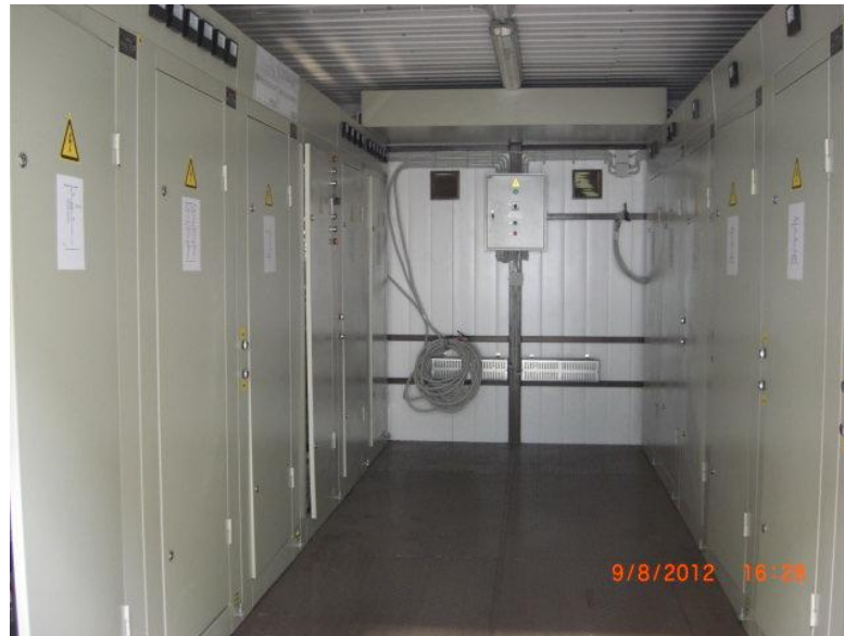
Фото 1. Распредустройство 0,4 кВ с установленными панелями ЩО70 с ШМР
