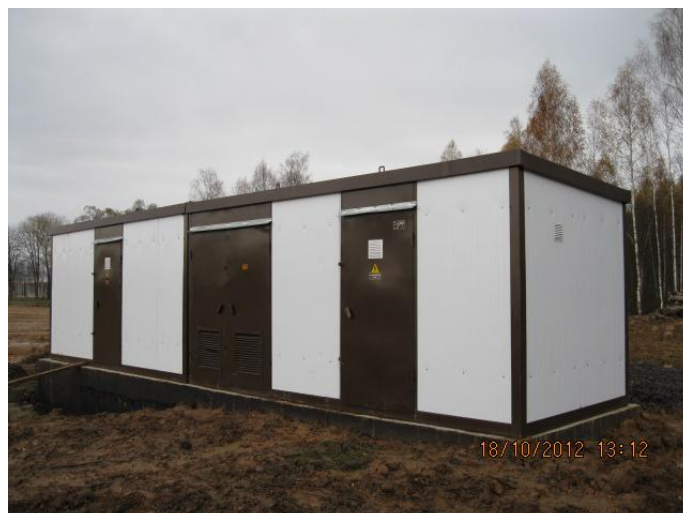
Фото 3. КТПНУ-400, утеплённая для ООО «Камчатка», г.Конаково, Тверская обл.
